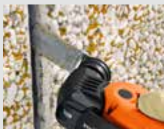
Zdrsnění boků spár před opětovným vyspárováním.
