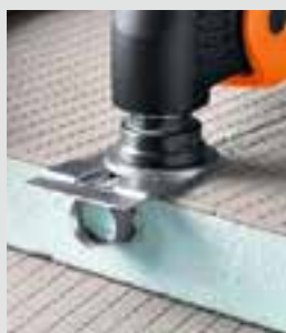
Výřezávání kanálů pro potrubí teplovodního podlahového topení.
