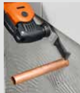
Řezání rovnoběžně se stěnou na minimálním prostoru.
