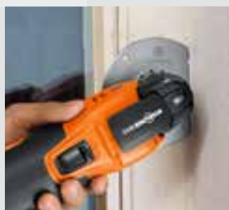
Protnutí kovových upevňovacích pásek při demontáži starých oken.
