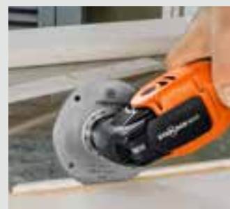
Protnutí hřebíků na zasklivačích lištách .
