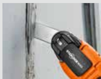
Odstranění elastických spárovacích těsnicích hmot v pozemních a inženýrských stavbách.
